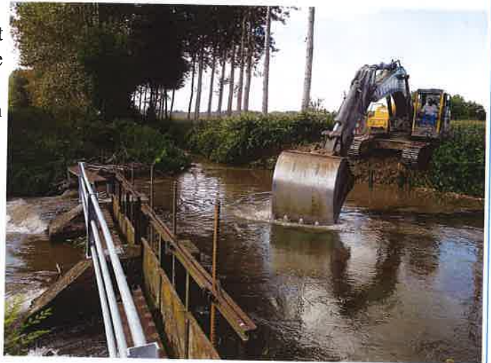
(Photo prise aux Huit Portes : la pelle en action, le garde-corps le long des vannes)
