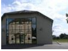
Bâtiment principal 410, Chemin du 5 Août 1944 BP 23
